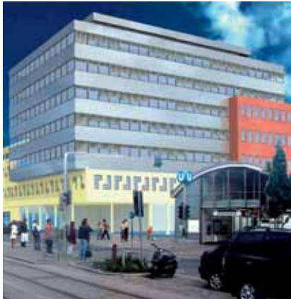
Projekt der IMMOFINANZ in Wien-Simmering: ca. 16.000 m 2 Büro- und Geschäftsflächen sind bereits vor Fertigstellung langfristig an BILLA, BIPA und das BBRZ vermietet.
